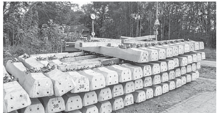
Hier warten neue Schwellen am Bahnhof Dalheim darauf, verarbeitet zu werden
