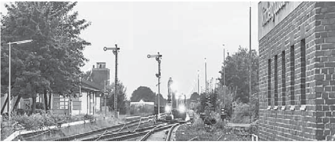
Bauarbeiten in Rheindahlen 2014
