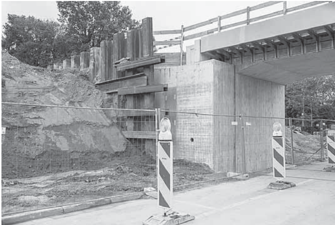
Neue Brücke Venloer Straße In Wegberg
