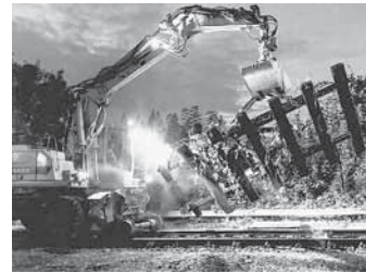
Bauarbeiten in Rheindahlen
