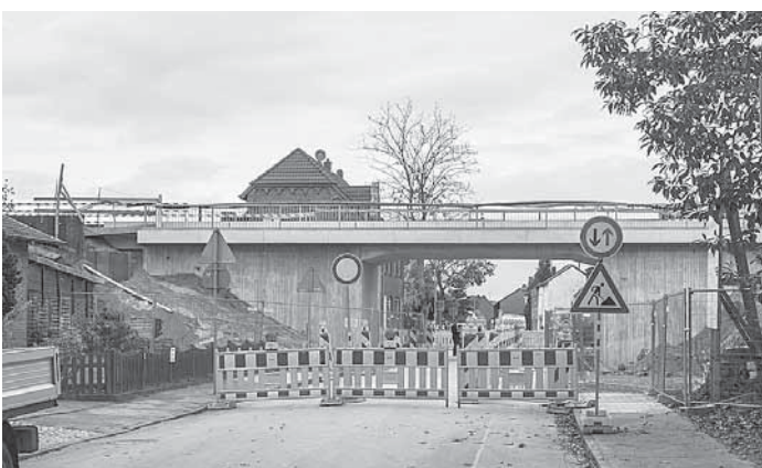
Neue Brücke über den Grenzlandring westlich von Wegberg
